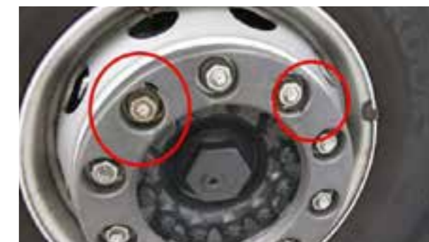
Pokrovi kotača: iskrivljeni, razbijeni, materijal nedostaje ili je skinut
